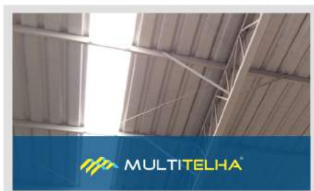
Telhas em policarbonato
